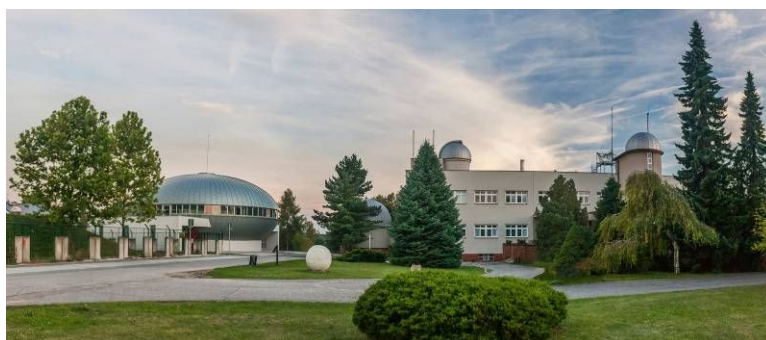
Budova hvězdárny a nového digitálního planetária.
